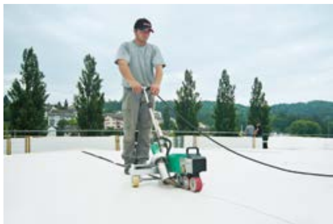
Automatenschweißung (Heißluft)
