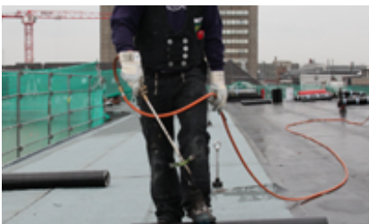
Komplett neuer Dachaufbau auf der Unterkonstruktion
